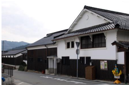
東面主屋の妻壁と意匠を合わせた倉庫
